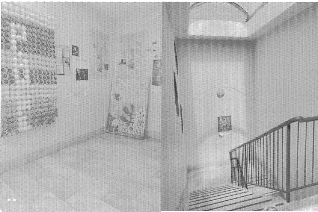
Fig. 4-5 Plesso Tommaso Onofri- Vano scala destinato agli interventi
