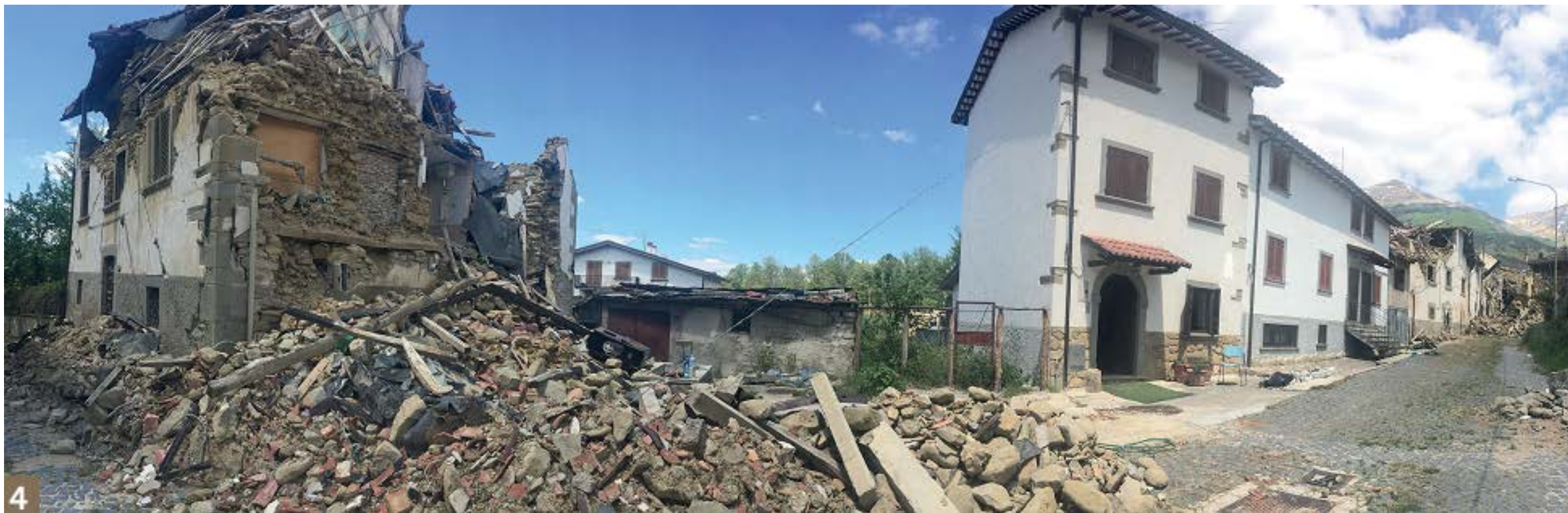
4 Sommati frazione di Amatrice (Ri): scenario catastrofico post-sisma, dove il solo edificio totalmente indenne è casa Di Giacomo.
