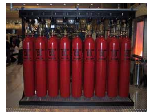
Impianto ad anidride carbonica
